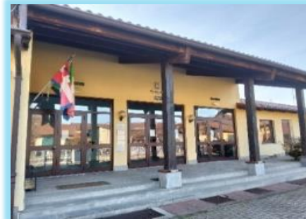
PRIMARIA- LOMBRIASCO VIA PRUSSERO, 9
